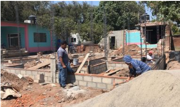
Continúa la construcción del Hospital General de Juchitán.
