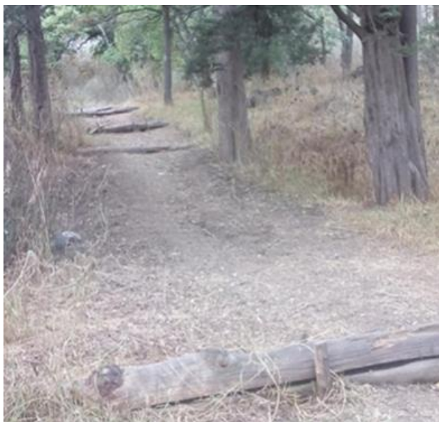
Obras para contener arrastres de suelo en lo alto de una cuenca
